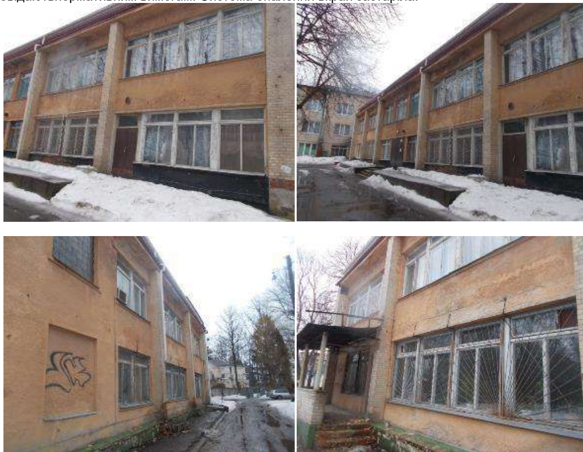
Рис. 1 Будівля до капітального ремонту
