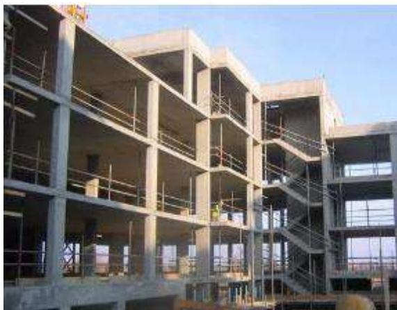
Рис.1 Будівля з монолітним каркасом
